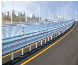
중앙분리대 | DS가드레일 SB4등급
